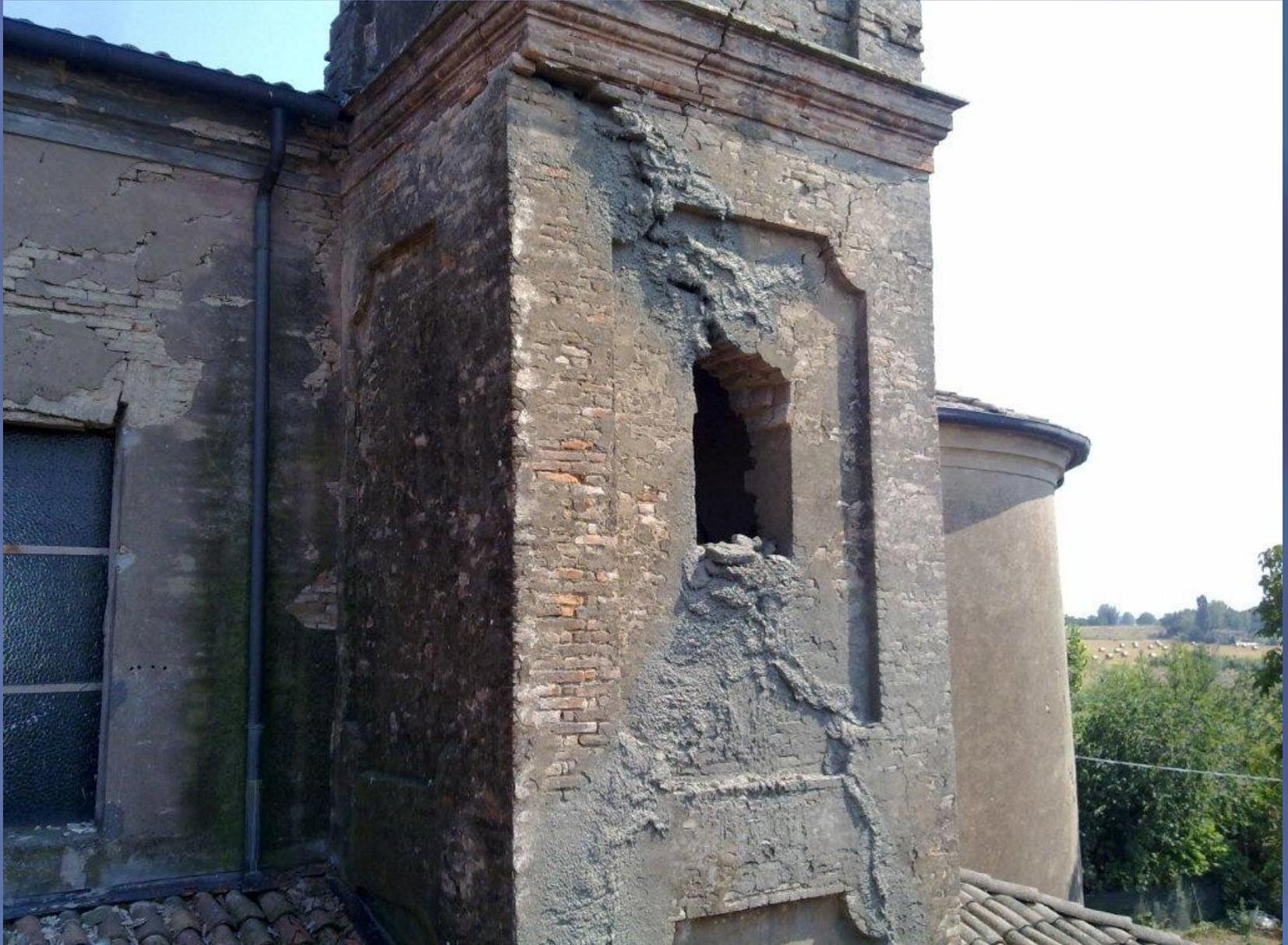
✦ Primo strato di intonaco strutturale e posa Fibra di confinamento
